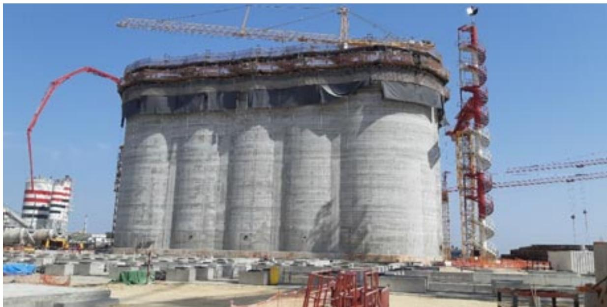
*Photo 5\_ Fabrication Caissons au port Page 15*
